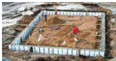
Encofrado de cimientos.
