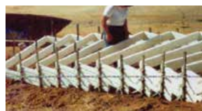
Encofrado de escaleras
