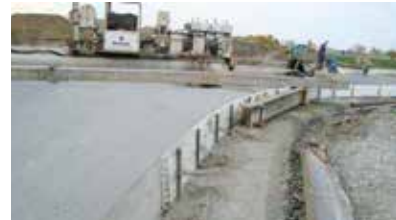
Encofrado para bordes curvos en carreteras.
